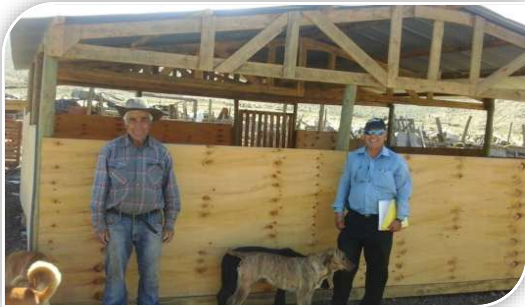
Proyecto IFP, construcción de corral caprino.
